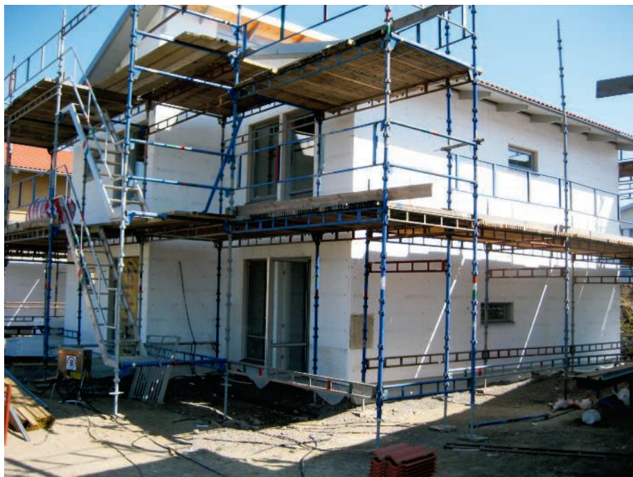
En fasad med cellplast på träregelstomme, innan den har putsats. Foto: Tomas Gustavsson
