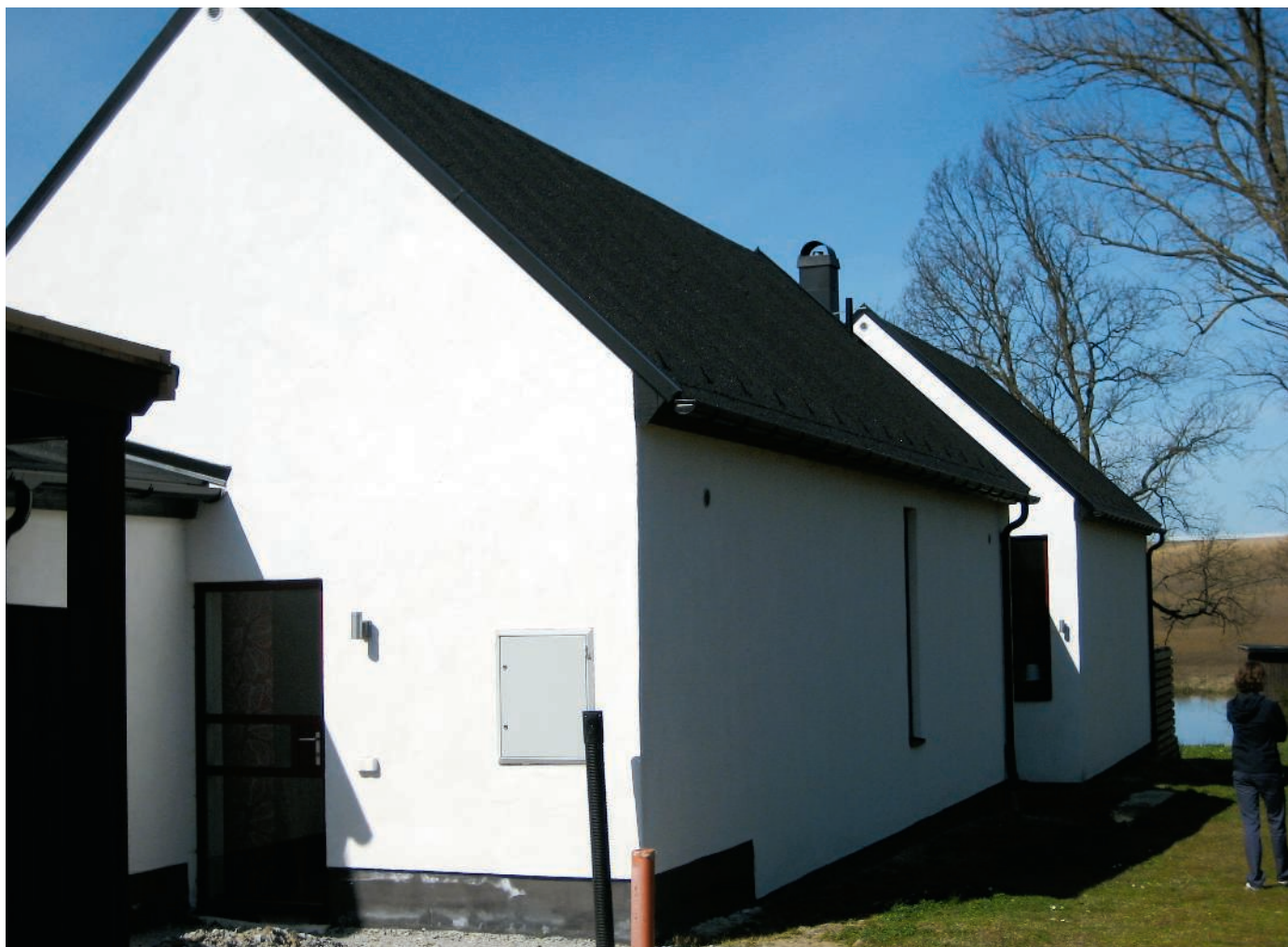
Huset är byggt med Porotherm. Här är det färdigputsat. Förutom fuktsäkerhet får man naturliga och logiska materialmöten med homogena murblock. Foto: Tomas Gustavsson
