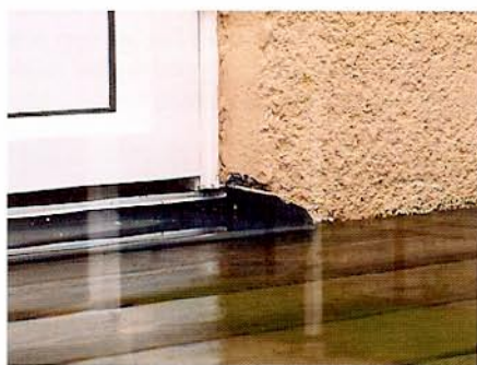
Bild 7: Otät i anslutning till altandörr.
