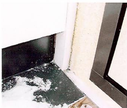
Bild 9: Otätheter vid sidoanslutning till balkong.
