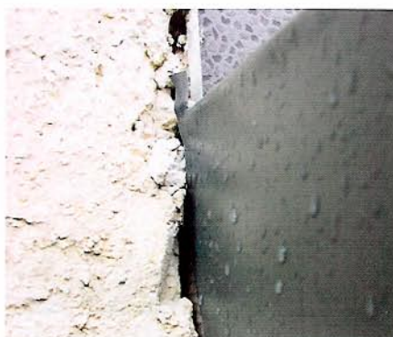
Bild 10: Otätheter vid skärmtaksinfästning.
